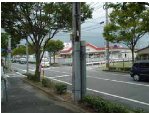
写真5 ケーブルの立ち上がり部
